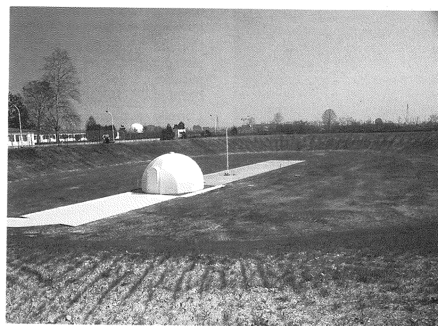
Fig. 11 - Impianto free-field per rilevamenti a 30 m realizzato presso il Centro di Ricerca e Sviluppo della Bull Italia a Pregnana Milanese. Per migliorare le funzionalità, l'impianto è realizzato al di sotto del piano di campagna, in un sito di forma ellittica appositamente scavato. La centrale di misura e comando è remota.
